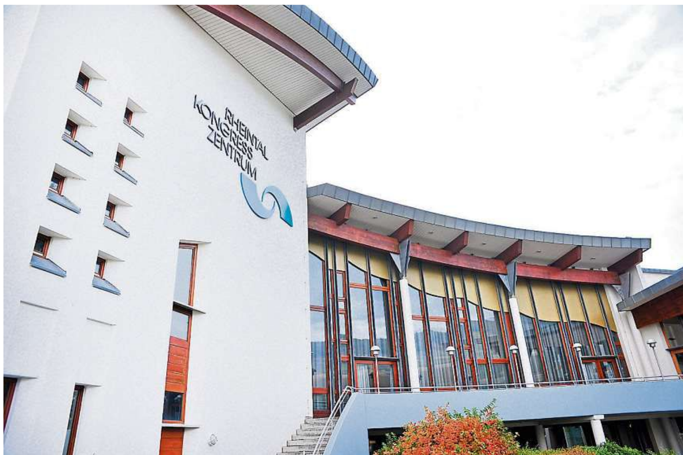
Im Rheintal-Kongresszentrum soll im Mai 2022 der Tourismus im Mittelpunkt stehen.
